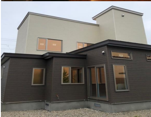
※写真は施工例です
